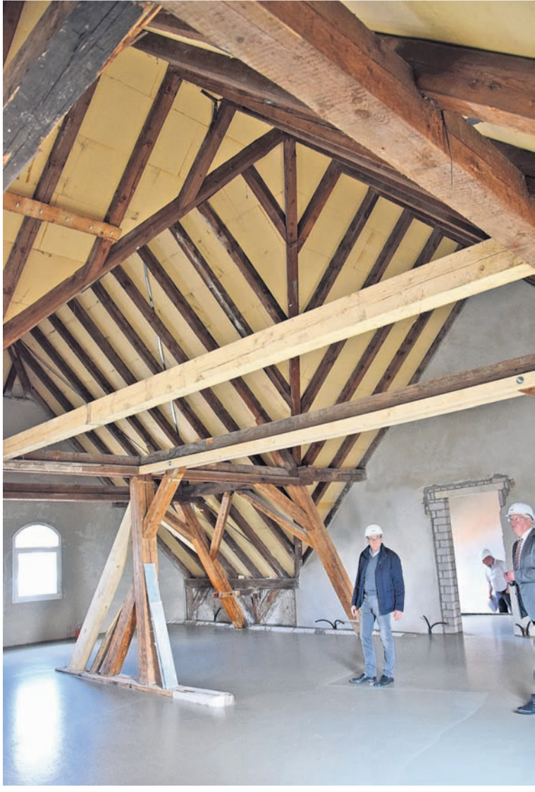
Von außen kaum zu erahnen, dass die Räumlichkeiten, die im alten Schulhaus im Erdgeschoß (links) und unter dem Dach entstehen, so großzügig sind. Die vorhandene Holzbalkendecke wurde aus statischen Gründen mit einer Betondecke verstärkt, der liegende Dachstuhl (rechts), ein Beispiel handwerklicher Zimmermannskunst, bleibt zum größten Teil offen und damit sichtbar. Fotos: Lorenz Märtl
