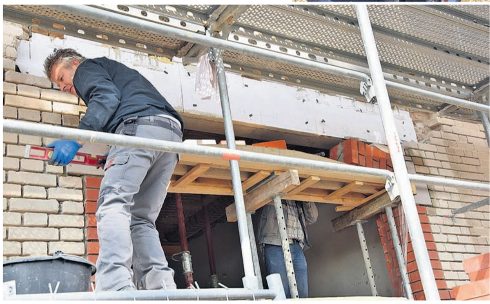
Handwerker mit Gespür und Können sorgen für eine exakte Rekonstruktion des früheren Eingangs.
