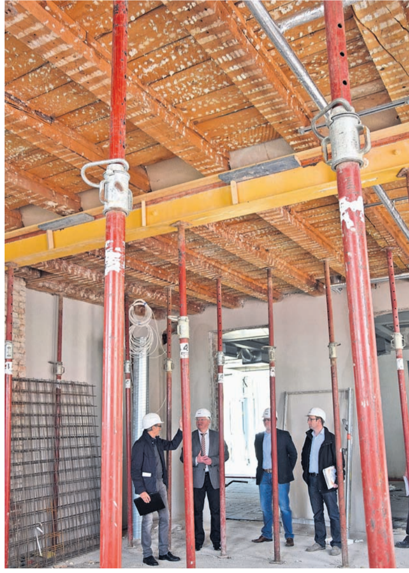
Von außen kaum zu erahnen, dass die Räumlichkeiten, die im alten Schulhaus im Erdgeschoß (links) und unter dem Dach entstehen, so großzügig sind. Die vorhandene Holzbalkendecke wurde aus statischen Gründen mit einer Betondecke verstärkt, der liegende Dachstuhl (rechts), ein Beispiel handwerklicher Zimmermannskunst, bleibt zum größten Teil offen und damit sichtbar. Fotos: Lorenz Märtl
