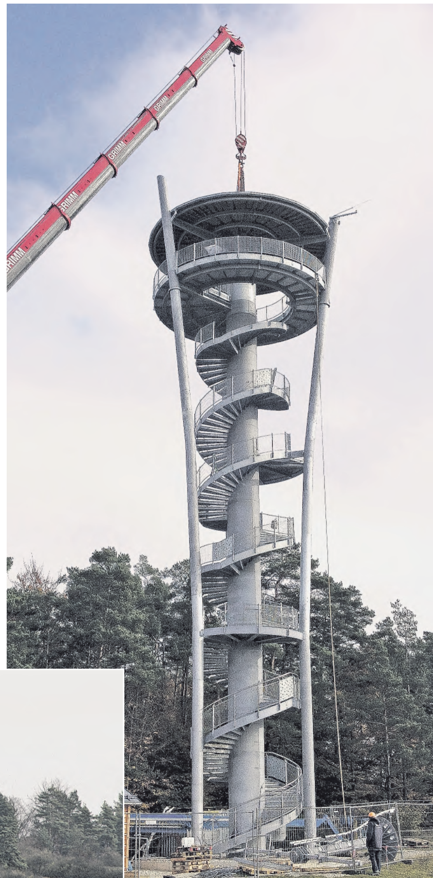
Hat das Zeug zur Touristenattraktion: der einzige Antennenmast in Bayern mit Aussichtsplattform bei Pottenstein (links). Per Kran wurde die Aussichtsplattform auf den Funkturm bei Pottenstein gehievt (oben).Fotos:Märtl
