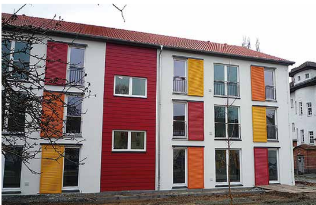
In einer Bauzeit von nur sieben Monaten entstand in der Röntgenstraße dieses moderne Mehrfamilienhaus für anerkannte Flüchtlinge und einheimische Bedürftige. Foto: red
