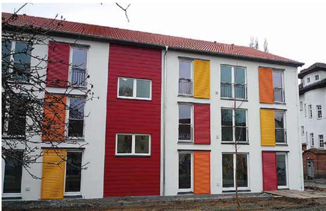
In einer Bauzeit von nur sieben Monaten entstand in der Röntgenstraße dieses moderne Mehrfamilienhaus für anerkannte Flüchtlinge und einheimische Bedürftige. Foto: red
